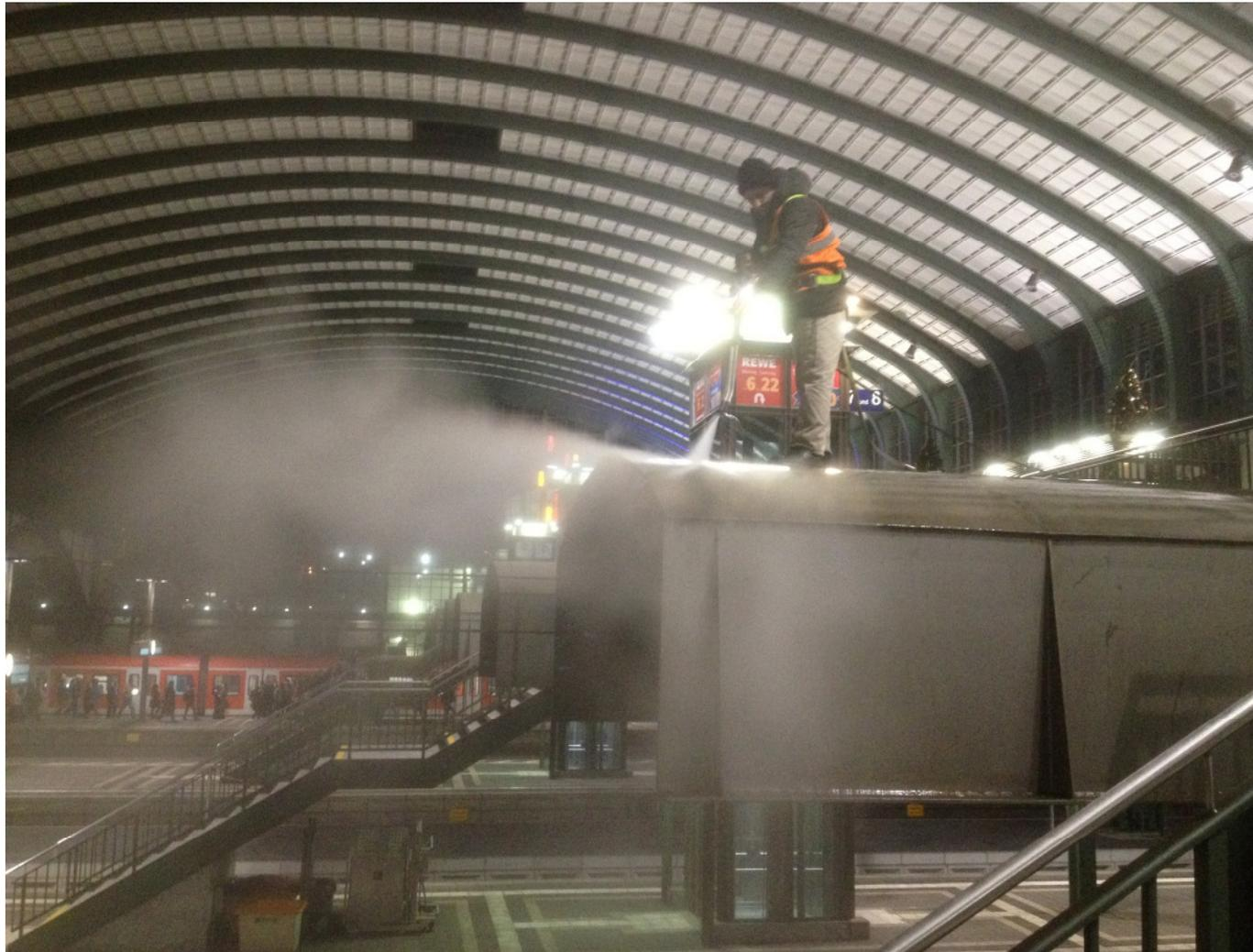
**... mit einem neuen Korrosionsschutzanstrich versehen, im laufenden Betrieb**
