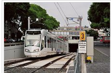
Eine RegioTram verlässt den Tunnel unter dem Bahnhofsgebäude stadteinwärts
