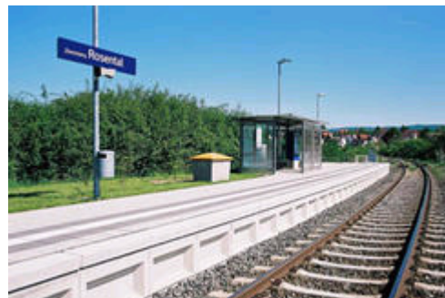
Leichter Zugang für alle: Mit barrierefrei angelegten Stationen und Bahnsteigen, die einen stufenlosen Einstieg ermöglichen.
