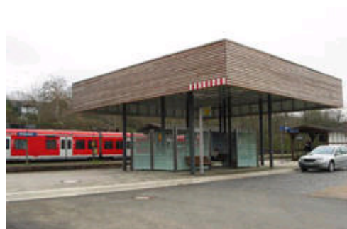
Optimale Mobilität im RegioTram-Netz mit neuen Park + Ride-Anlagen und neuen Busbahnhöfen.
