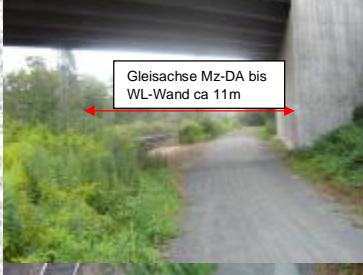
Gleisachse Mz-DA bis WL-Wand ca 11m
