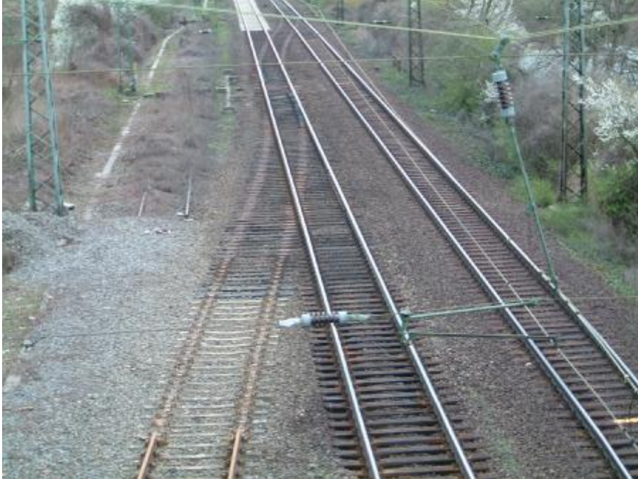
Abb. 3. Südkopf des Bahnhofs Zwingenberg an der Main-Neckar-Bahn Frankfurt – Mannheim/Heidelberg mit ausgebauter Weichenverbindung und abgeklemmtem Überholgleis. (Foto Otmar Ginkel, 22.3.2004)
