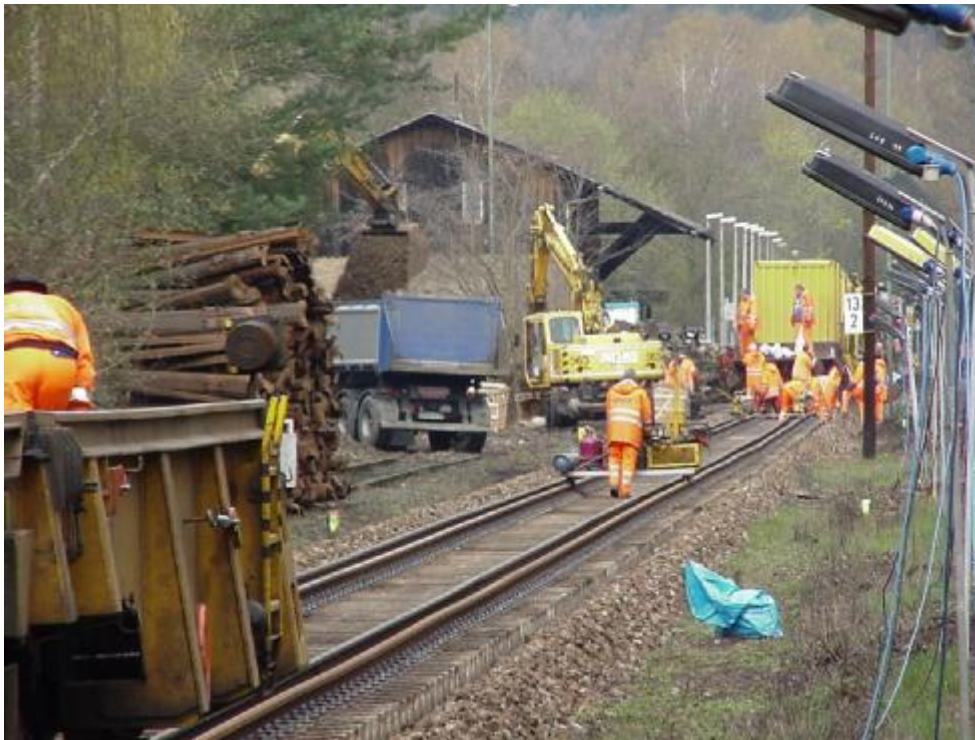
Abb. 4. Zwischen 05. und 08.04.2004 war die Strecke zwischen Darmstadt Ost und Ober-Ramstadt für den Schienenverkehr gesperrt – es wurde Schienenersatzverkehr durchgeführt. Zum Einsatz kamen Gleisbauzüge der Firma Spitzke sowie 4 altrote V100 der EfW, 212 089-7, 212 057-4, 212 047-5 und 212 370-1. Bei den Arbeiten wurden nicht nur Gleise grunderneuert, sondern auch Schienen ausgebaut. (Foto Volker Gelmroth)
