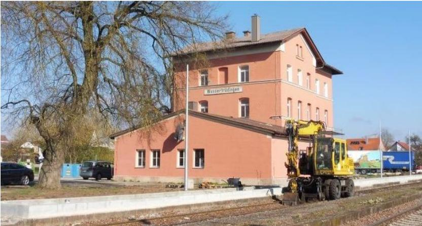
*Im März hat die BayernBahn ohne Unterstützung durch öffentliche Mittel den Hausbahnsteig in Wassertrüdingen auf 55 cm erhöht. Der Einstieg in die derzeit verkehrenden DB-Triebwagen der Baureihen 642 und 648 ist damit ebenerdig. (Bild: T. Stenzel)*
