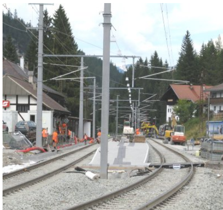
Links: Bau des neuen Mittelbahnsteigs in Ehrwald. Rechts: Gleiserneuerung an einem Bahnübergang bei Lähn (Bilder: M. Wiegner)
