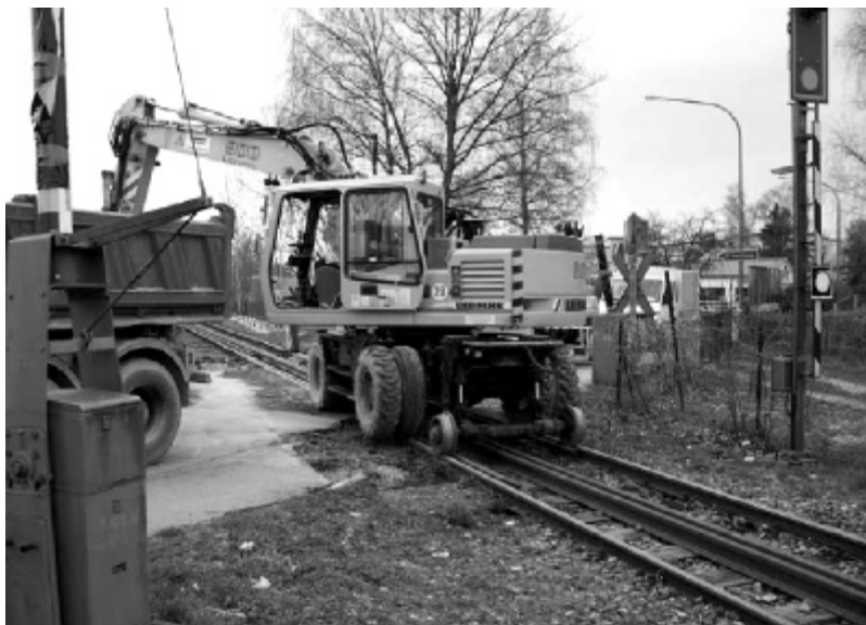
Arbeiten am Bahnübergang Munastraße
