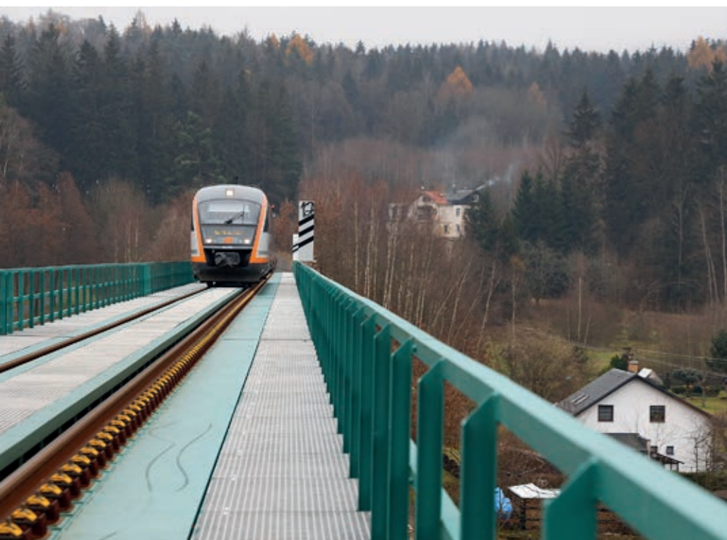
Vilémovský viadukt postavený v roce 1903 společně s úsekem trati Mikulášovice – Sebnitz a kompletně zrekonstruovaný v letech 2020–21 překlenuje údolí Vilémovského potoka v maximální výšce 34 metrů v délce 225 metrů.
