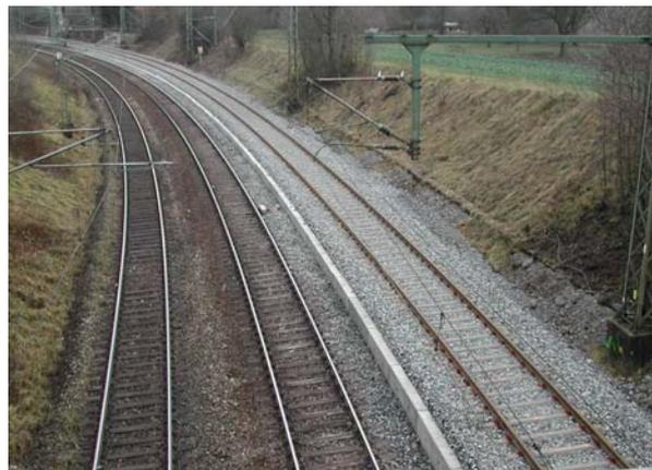
In beiden Bildern ist die neue Stützmauer zu sehen, ebenso das neu eingeschotterte Gleis.
