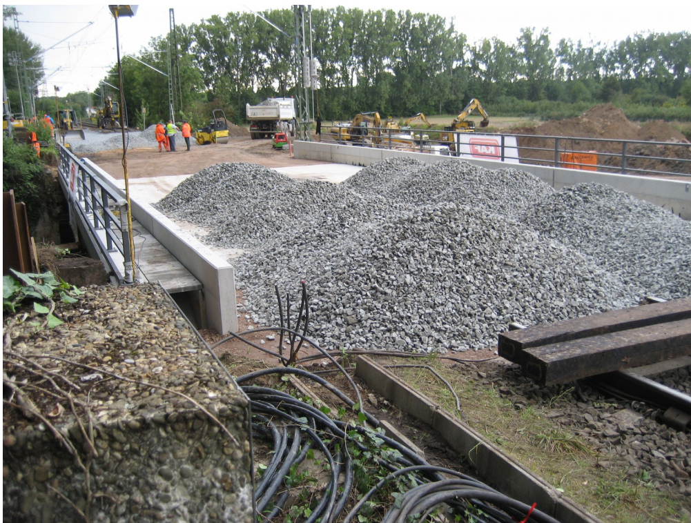
Main-Rhein-Bahn: Erneuerung der Gersprenzbrücke westlich Bahnhof Dieburg (G. Gienger, 24.8.2014)
