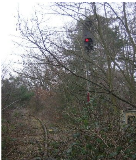
Abb. 3. Es steht noch immer funktionstüchtig mitten im Wald - das Einfahrtsignal des Bahnhofs Darmstadt-Eberstadt aus Richtung Pfungstadt. Aufgenommen am 15.03.2009 (Copyright Bahnhof Mühlital)
