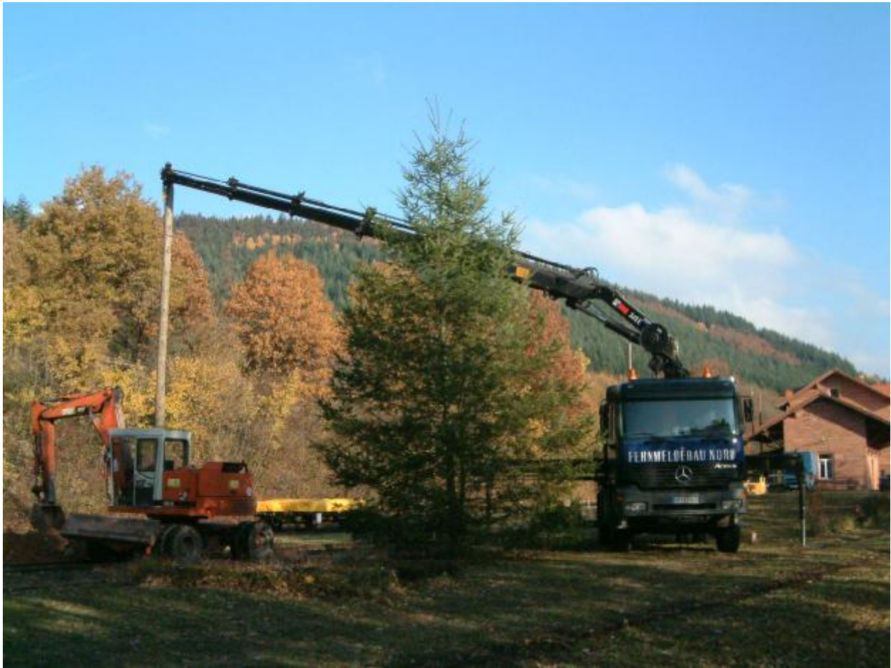
Abb. 4. Aufstellung von Beleuchtungsmasten am Bahnhof Kailbach: Eine Privatinitiative im Vorgriff auf die Modernisierung der Odenwaldbahn, Okt. 2003 (Foto Richard Lichtenstein)
