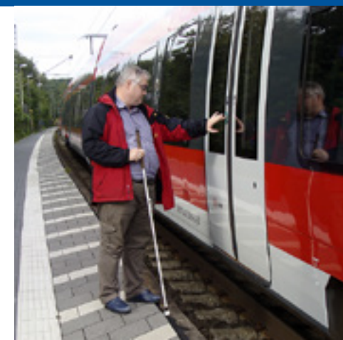
Nur sanierter, aber nicht grundhaft erneuerter Bahnsteig an der Main-Weser-Bahn. Die Bahnsteighöhe ist weiterhin bei 38 cm und daher nicht barrierefrei.
