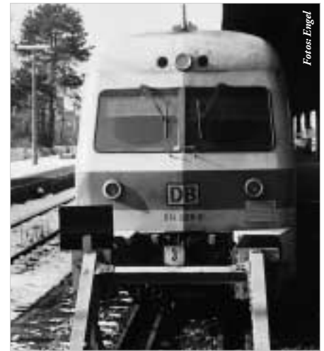
Der Wagenkasten des Nachfolgemodells 614 hatte einen Wagenkasten, der für die Neigetechnik oben abgeschrägt war. Aber hier wurde sie nie eingebaut.
