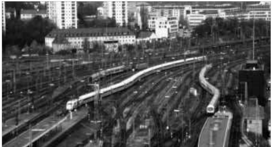
Der Blick vom Turm: ein verwirrendes Gleisfeld, über das sich die Züge den Weg suchen. Doch der Schein trügt: Ein neu geordneter Kopfbahnhof kann das Vierfache des heutigen Fahrplans verkraften und fast doppelt so viel wie der geplante Durchgangsbahnhof. Die Schlanglinien wären im reformierten Kopfbahnhof Vergangenheit.
