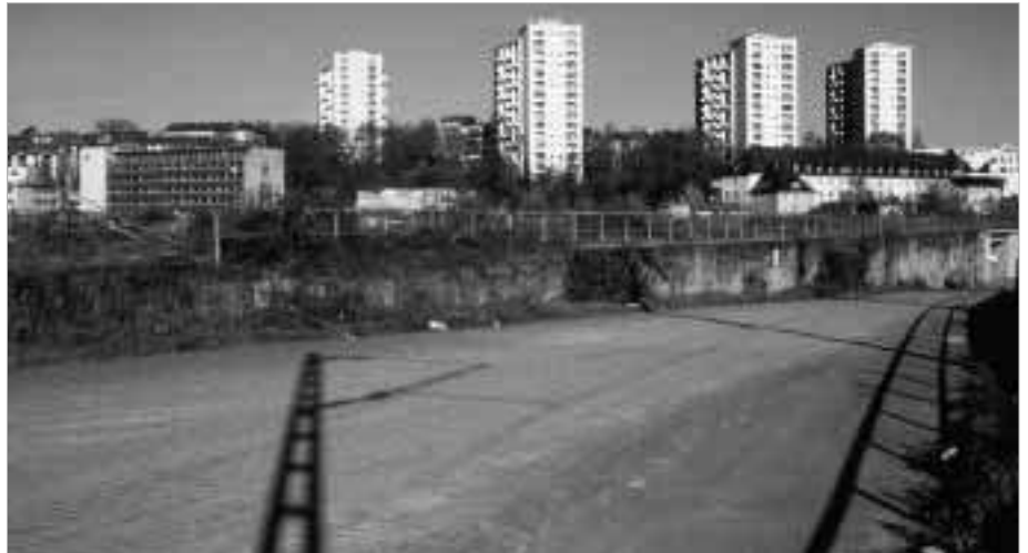
Die Kosten für die Freimachung des zu verkaufenden Bahngeländes werden unterschätzt. Das Gelände links ist bereits schienenfrei, rechts fahren die Züge zum Hauptbahnhof. Wie viel soll es kosten, bis diese „Landschaft“ an der Wolframstraße an Investoren verkauft werden kann?
