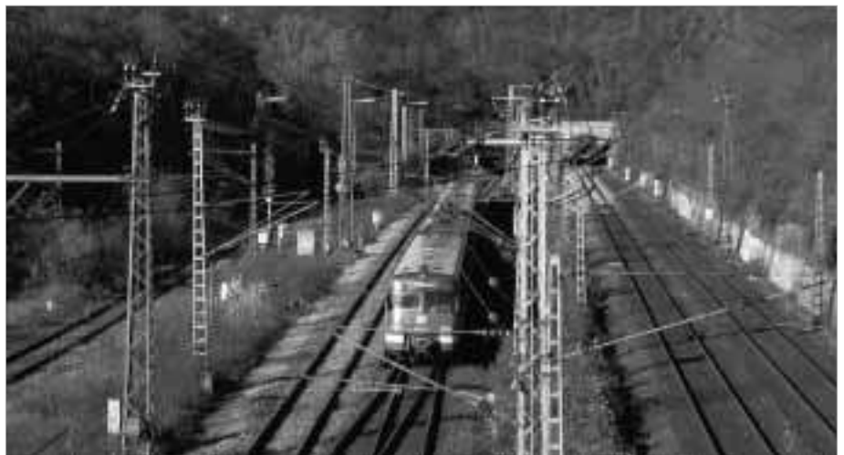
Der wahre Engpass ist der Pragtunnel und die Zufahrtstrecke von Zuffenhausen: Regional- und Hochgeschwindigkeitszüge aus Heilbronn, Frankfurt/Mannheim und Karlsruhe müssen sich ein einziges Gleis je Richtung teilen. Dabei soll es bleiben – auch die Zufahrt zum Tiefbahnhof soll nur zweigleisig sein. Die anderen zwei Gleise (links) dienen der S-Bahn. Die Beibehaltung des Kopfbahnhofs würde es ermöglichen, zwei weitere Gleise zu vertretbaren Kosten zu bauen.
