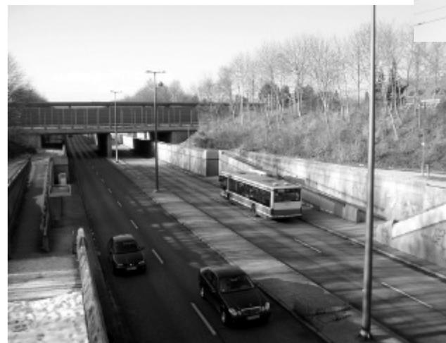
Alles aus einem Stück Beton gegossen: Ost-„Ansicht“ mit der Unterführung Von-Kahr-Straße einschließlich stadtauto-bahnmäßiger Bushaltestelle (Linien 164, 165).
