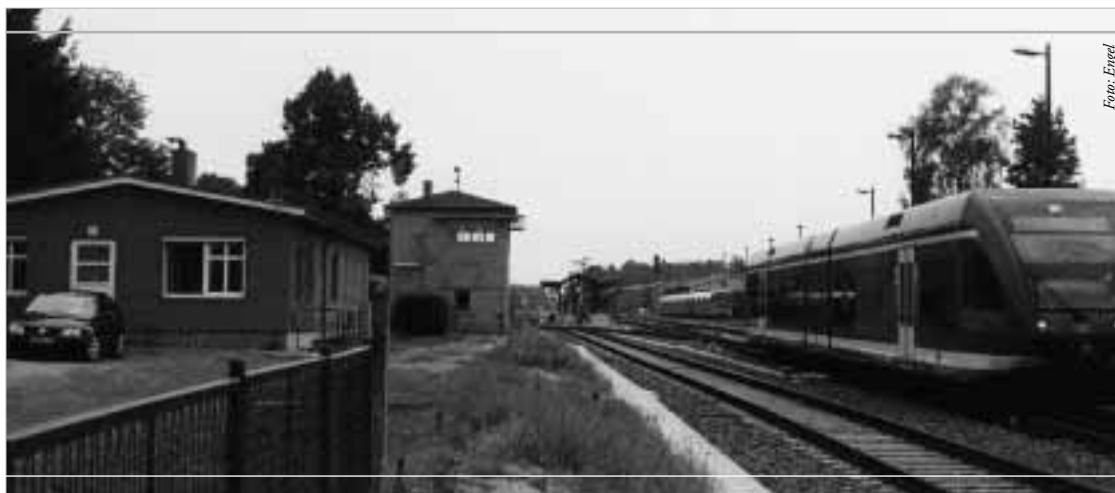
Hier zahlt die DB selbst: Die Niederbarnimer Eisenbahn verlangt rund vier Euro. Ein Zug passiert das neue elektronische Stellwerk (ganz links) in Basdorf.
