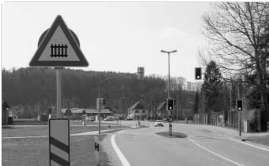
Nur hier weiß der Autofahrer, was ihn erwartet. Aber 240 Meter vor dem Bahnübergang wird auf die Gefahr viel zu früh hingewiesen.
