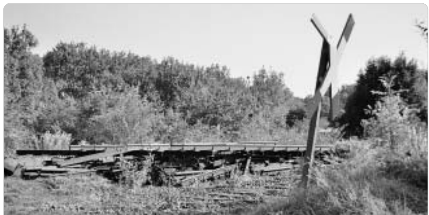
Andreaskreuz ohne Bahnstrecke: Laut Straßenverkehrsordnung muss dem „Bahnverkehr“ selbst an diesem verbeulten Relikt Vorrang eingeräumt werden. Gemäß dem Eisenbahnkreuzungsgesetz darf das Schild nicht entfernt werden, auch wenn gar keine Züge mehr fahren.
