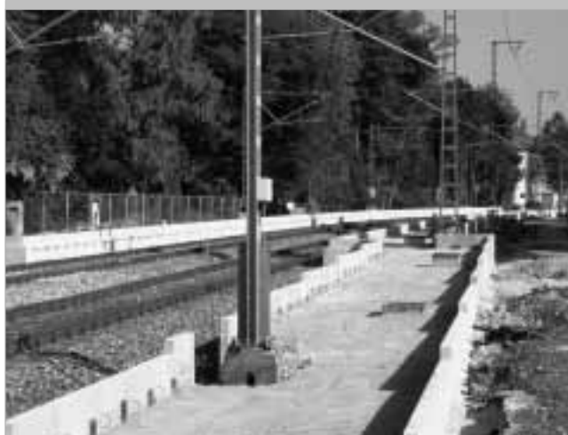
Zu teuer gebaut? Neue Haltestelle Lörrach-Schillerstraße im Bau.
