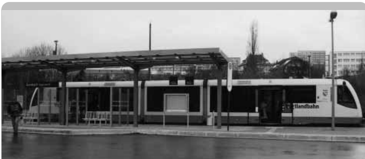
Vor Ort billiger gebaut. Diesen Bahnhof baute die Stadt Annaberg und übergab ihn dann an die DB.
