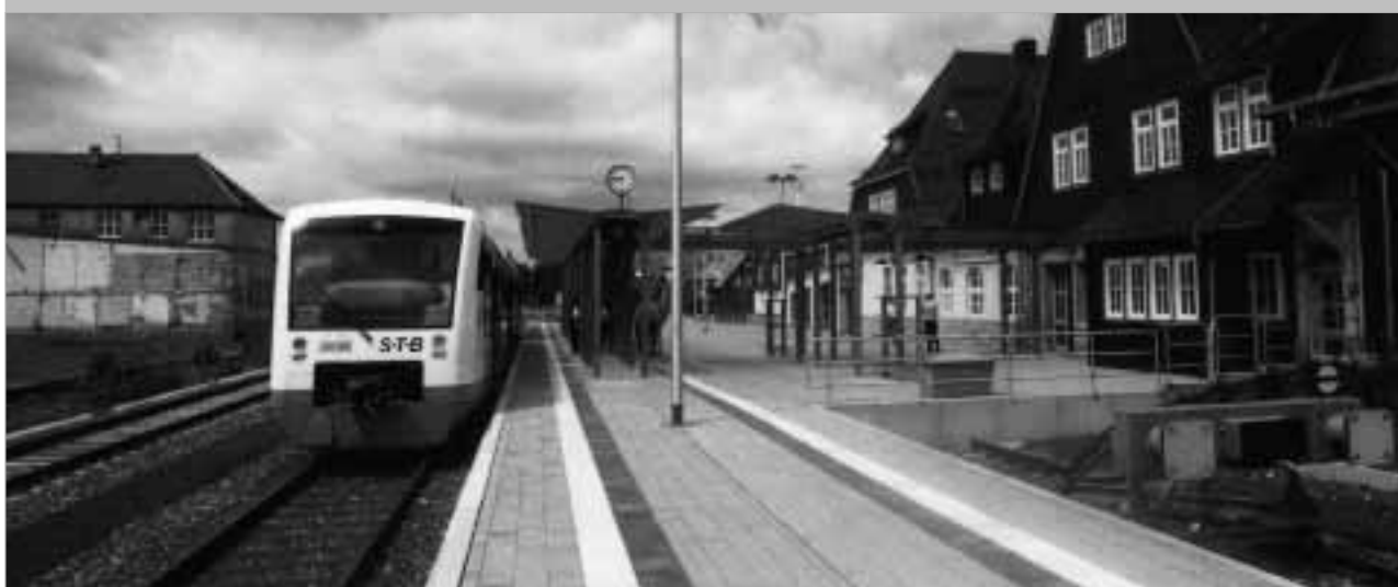
Neuhaus am Rennweg: Gleise und Station lokal geplant und gebaut von der Thüringer Eisenbahn-Gesellschaft.
