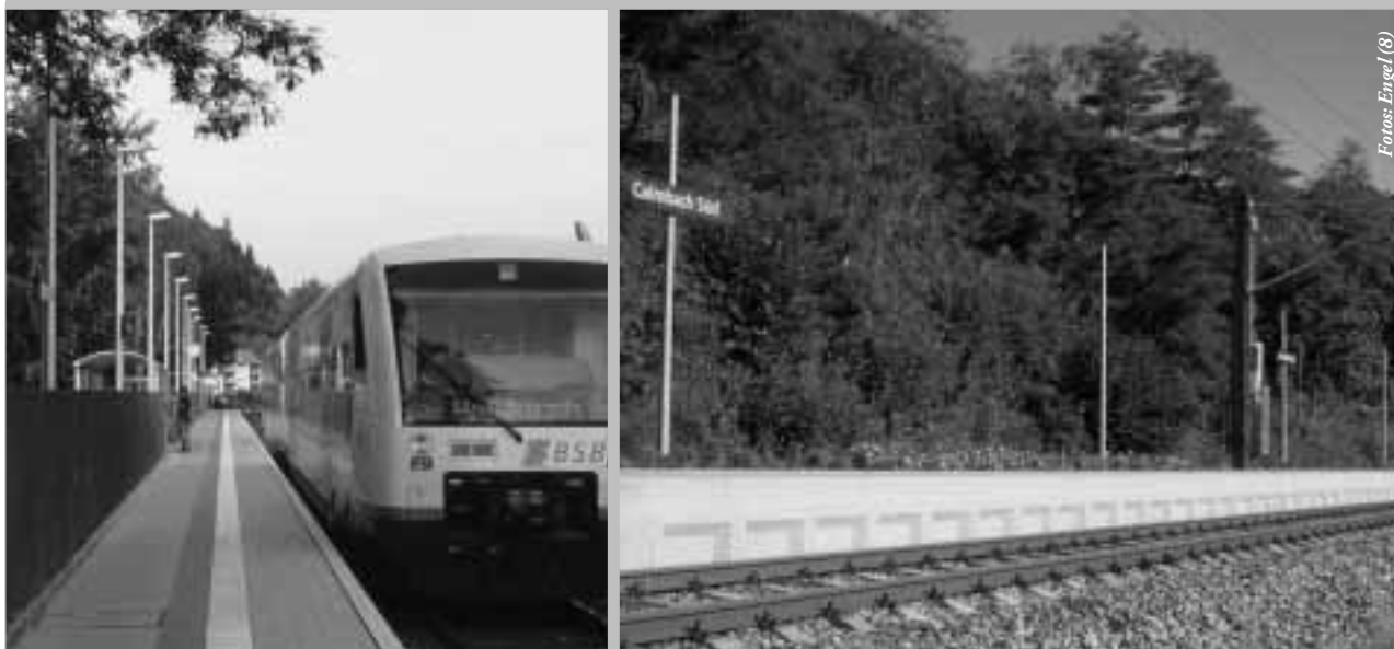
Links: Große Festbeleuchtung für den kleinen Zug: nur zwölf Meter Abstand zwischen den Leuchten an der Station Batzenhäusle an der Regio-S-Bahn Freiburg – Elzach. Rechts: Angepasste Beleuchtung: Haltepunkt Calmbach Süd, Strecke Pforzheim – Bad Wildbad.
