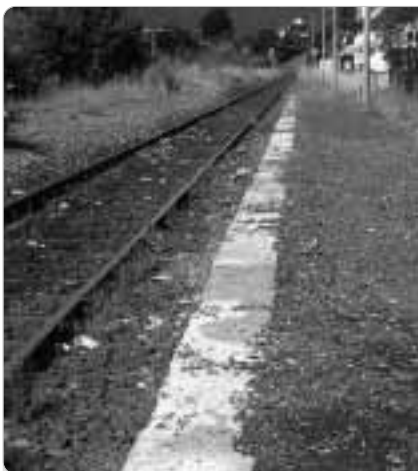
Haltepunkt Schmalnau vor der Sanierung...
